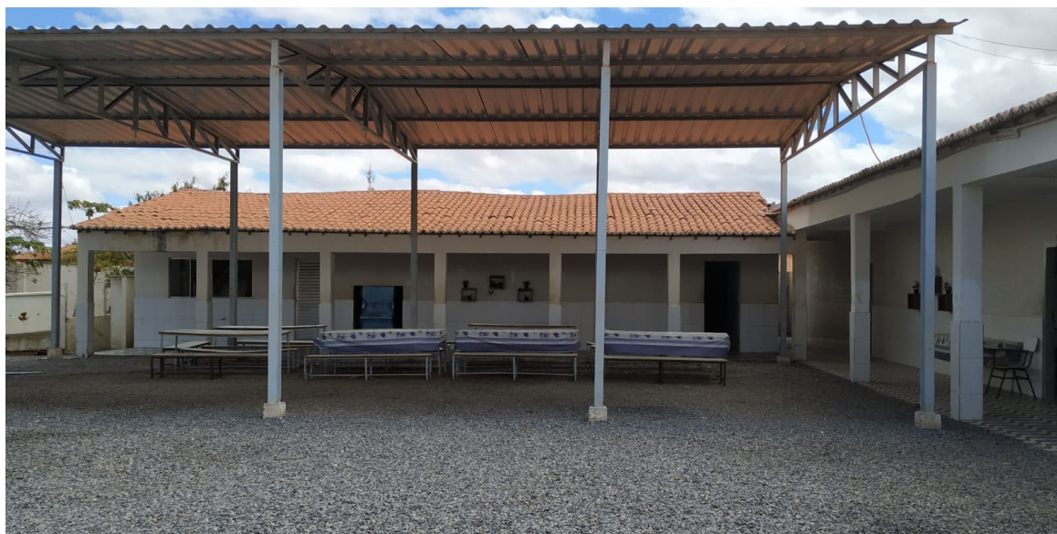
IMAGEM 03: Área externa (Cobertura metálica). Arquivo do Autor 2021
