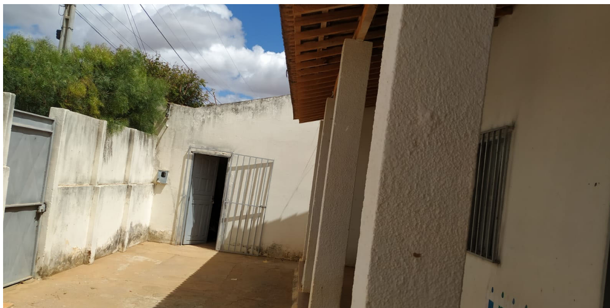
IMAGEM 06: Área externa (salas e cozinha). Arquivo do Autor 2021.
