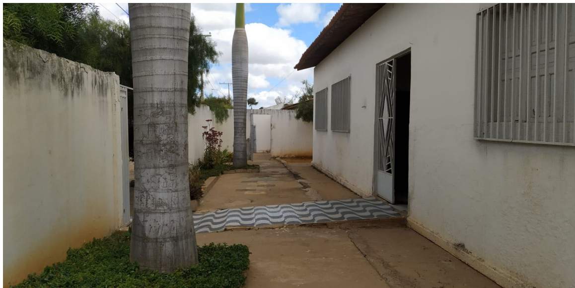
IMAGEM 01: Vista frontal parte externa. Arquivo do Autor 2021
