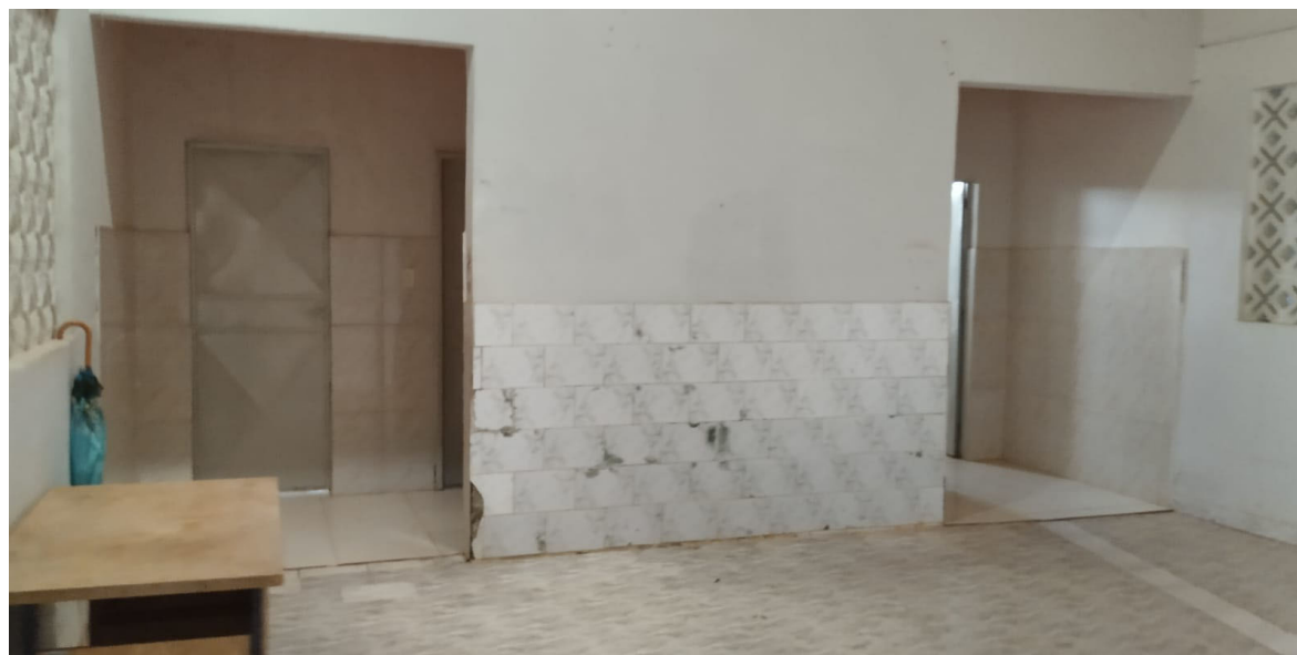
IMAGEM 04: Área interna (Sanitários). Arquivo do Autor 2021
