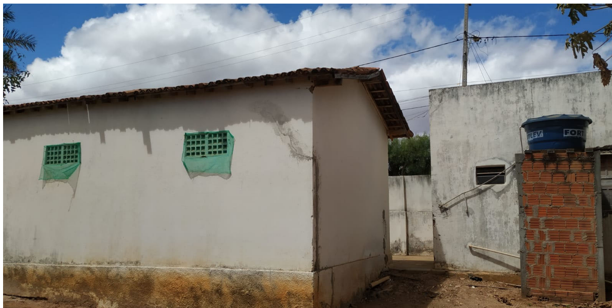
IMAGEM 05: Área externa (Salas e Cozinha). Arquivo do Autor 2021
