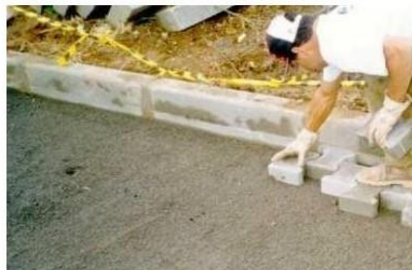
Foto 04/05/06 – Camada de assentamento
