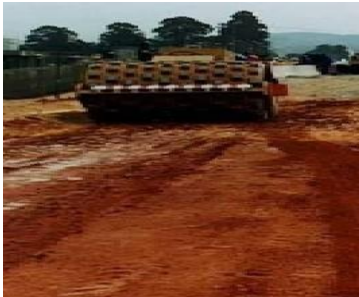
Foto 01 – Compactação do subleito
