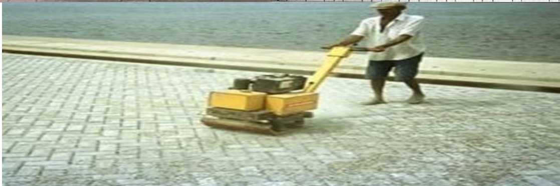
Foto 05 – Assentamento, arremates, rejuntamento e compactação
