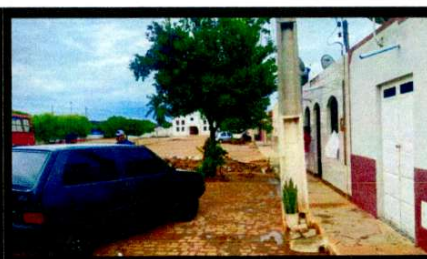
Figura 3 – Vista da Rua da Igreja: imóvel à direita; Igreja São José ao fundo – área central do Pov. Soares
