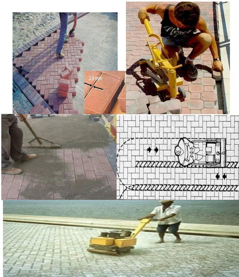
Foto 05 – Assentamento, arremates, rejuntamento e compactação
